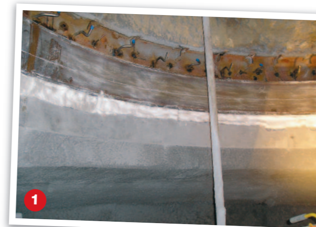
Ein Stahlring wird in das Dach des Zyklons geschweißt.
