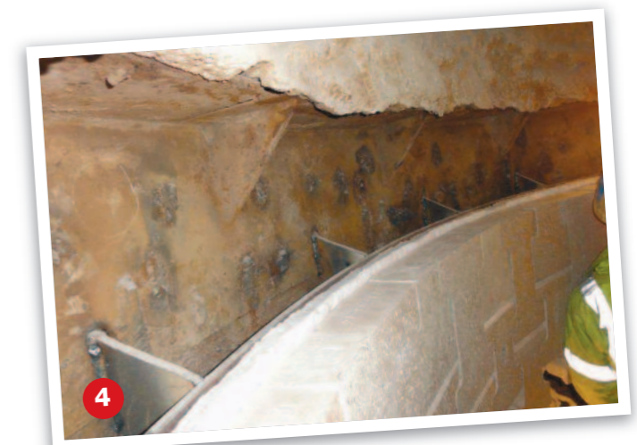
Der oberste Ring der vorgefertigten Elemente ist eingesetzt.
