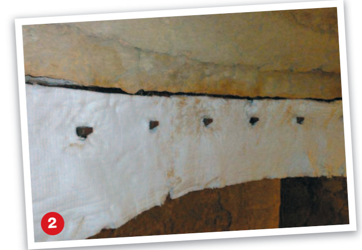
Eine Lage aus Keramikfasern ist eingesetzt – um Wärmedehnung zu ermöglichen
