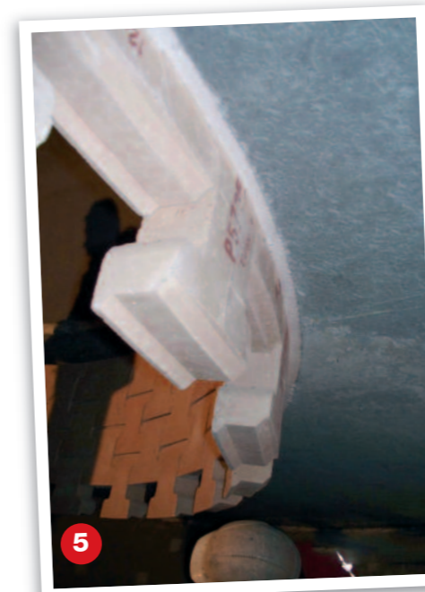
Die keramischen Fasern wurden passgenau beschnitten.
