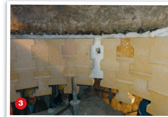
Fertig zum Schließen des obersten Modulrings auf den Hängeträgern
