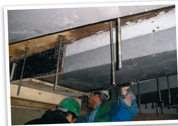
Gießen des Zyklondachs, Tschechien
