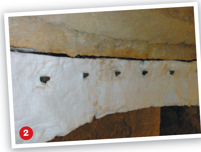
Eine Lage aus keramischen Fasern ist eingesetzt – um Wärmedehnung zu ermöglichen
