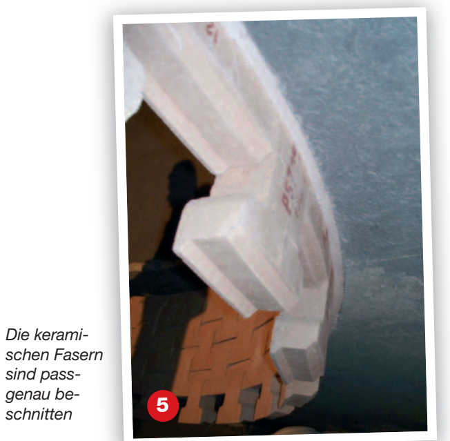
Fertig zum Schließen des obersten Modulrings auf den Hängeträgern
