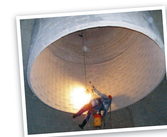
Wartung eines CVF, Tschechien. Ein Mitarbeiter inspiziert hier auf ungewöhnliche Weise. Normalerweise erfolgt die Inspektion visuell vom Schacht aus oder durch das Errichten eines Gerüsts
