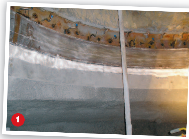
Ein Stahlring wird in das Dach des Zyklons geschweißt.
