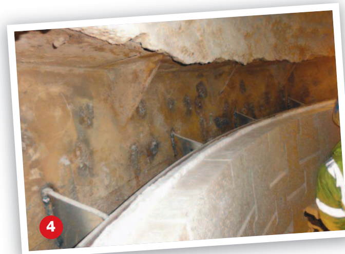
Der oberste Ring der vorgefertigten Elemente ist eingesetzt.
