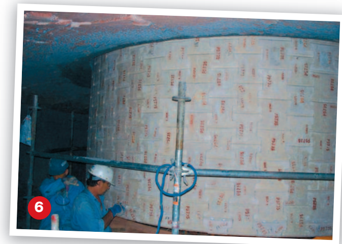
Die letzten Elemente werden verschlossen.
